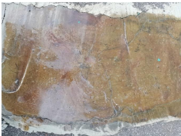
Рисунок 3. Нанесение полимерной композиции ЭГАиБ Figure 3. Application of the EGAiB polymer composition
