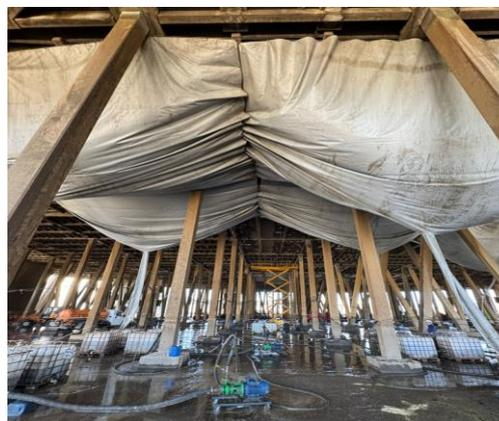
Рисунок 3. Исполнение защитного водосборного зонта
