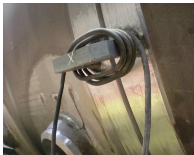
Рисунок 5. Пример катушки кабеля на скобу при выполнении размагничивания сборки для сварки технологического шва
