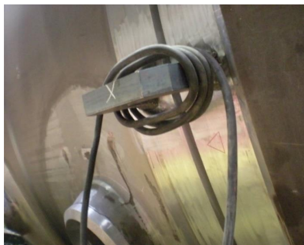
Рисунок 5. Пример катушки кабеля на скобу при выполнении размагничивания сборки для сварки технологического шва
