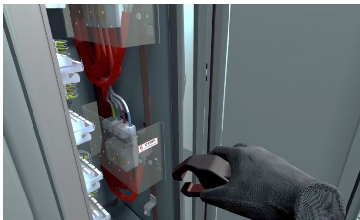
Рисунок 6 – Снятие токовых сигналов в шкафах НКУ, применяемых на АЭС [Current readings in NPP switchgear and controlgear cabinets]
